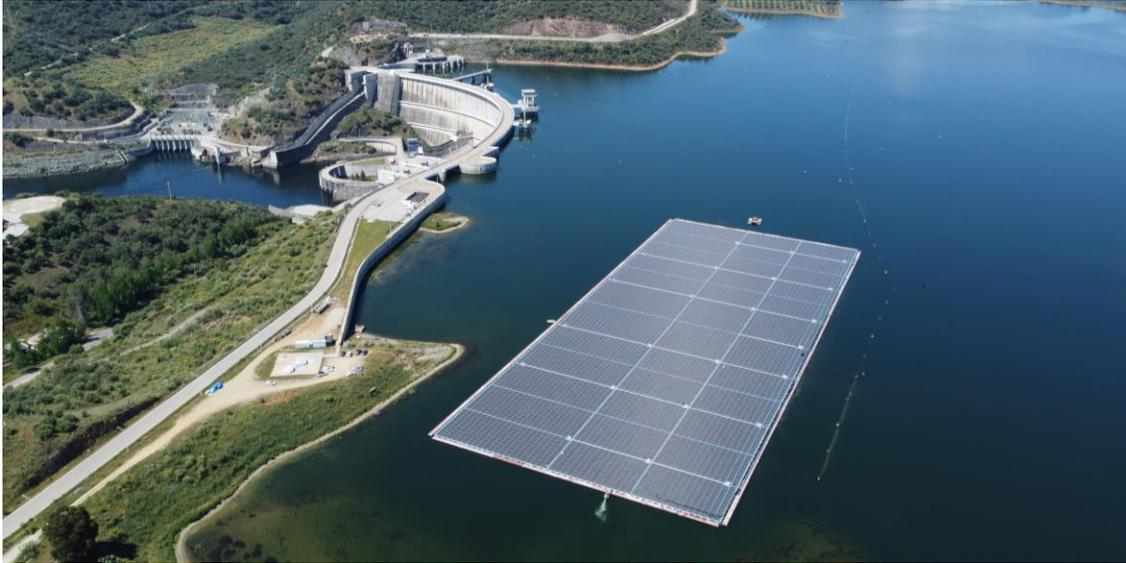
Diseñado para instalar plantas solares flotantes en múltiples cuerpos de agua: balsas de irrigación, hidroeléctricas, lagos naturales, plantas de tratamiento de agua, lagos de cantera, granjas de piscicultura y otros
